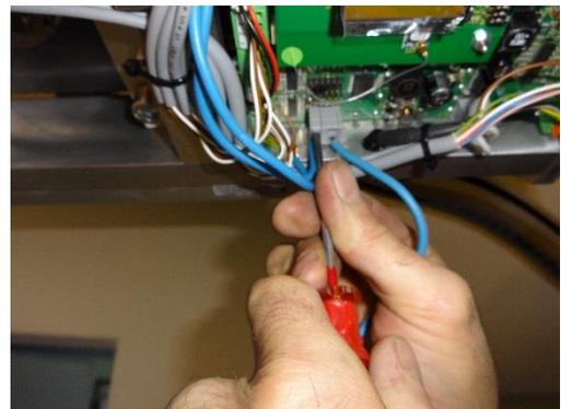
3. Anschliessend wird der Stecker mit der Kabelrolle verbunden. Die Kabel noch mit dem Splint gegen Ausreissen sichern. Rot oder Blau spielt keine Rolle (Wechselspannung).
