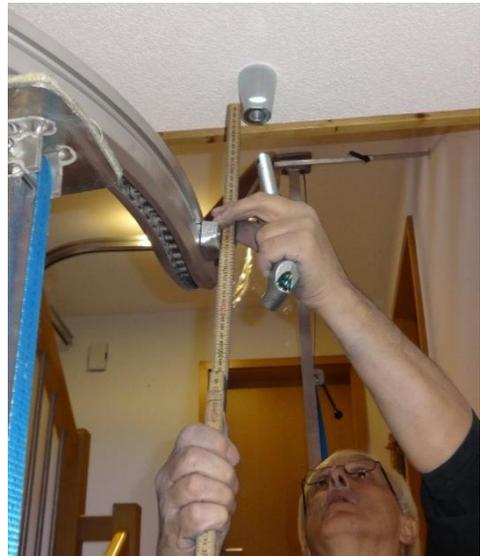
10. Aufhängebügel komplett montieren. Die Mutter M20 an der Rosette festziehen.
