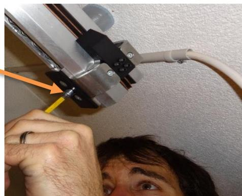
8. Auf der Schaltplatine wird die Fahrgeschwindigkeit auf Einpressgeschwindigkeit gestellt. DIP Schalter 8 auf Pos „ON“ und mit Taste TA2 bestätigen. 0.08m/s sollte Werksmässig eingestellt (auf On) sein.
