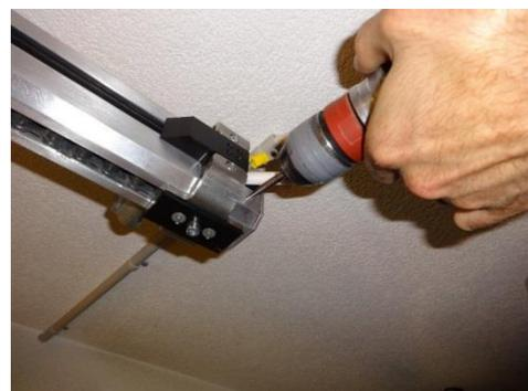
4. Beim Netzgerät werden die Kabel fürs Einpressen demontiert und anschliessend die Zuleitung zur Schiene montiert.
